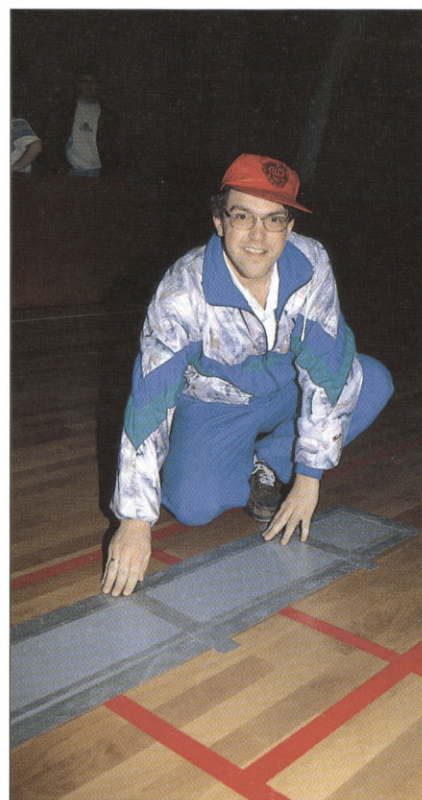
Ib Østergård fra Fredericia Fag- og Firmaidrætsforening viser her, hvor den store lampe ødelagde halgulvet, da den midt under stævnet bragede ned i gulvet. Heldigvis kom ingen noget til ved uheldet.
