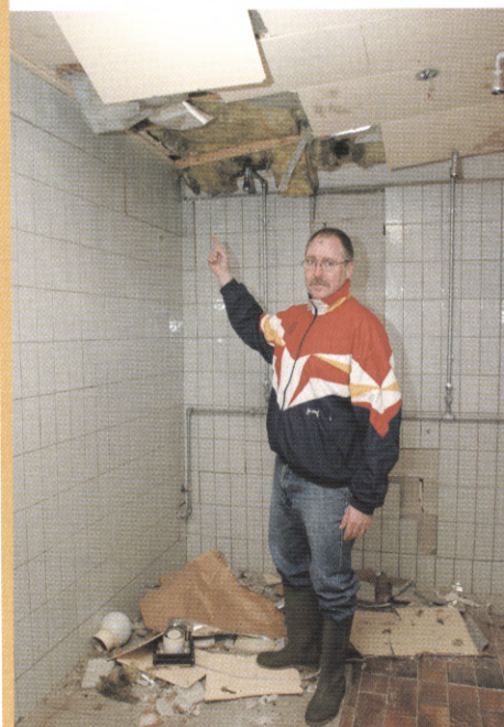
Da den – eller de – store fem tomers krysantembomber sprang, gik det ikke alene udover de offentlige toiletter, mens også et af baderummene. Karl Gustav Sørensen forudser, at flere af murene skal skiftes ud. Det samme skal måske også taget, der har løftet sig af det voldsomme lufttryk.
