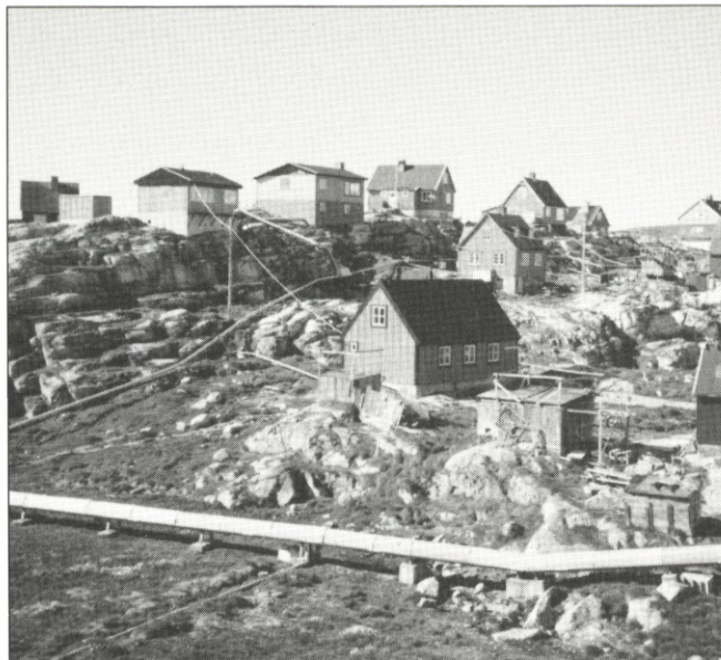
Klipper og frost er en dårlig kombination i forhold til kloakering, derfor bliver rørene lagt over jorden i de grønlandske byer
