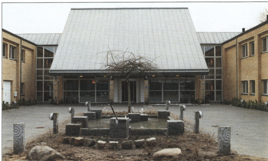
Midterfløjen med hovedindgangen rummer reception og lagerlokaler, og på 1. sal er der mødelokaler og kantine.
